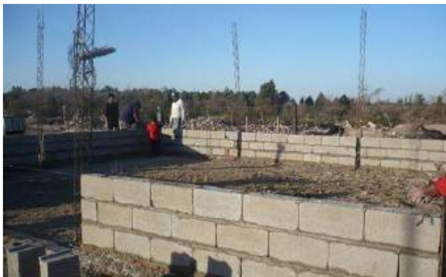
Fotografía 4. Construcción del galpón de la cooperativa Todo Sirve.
