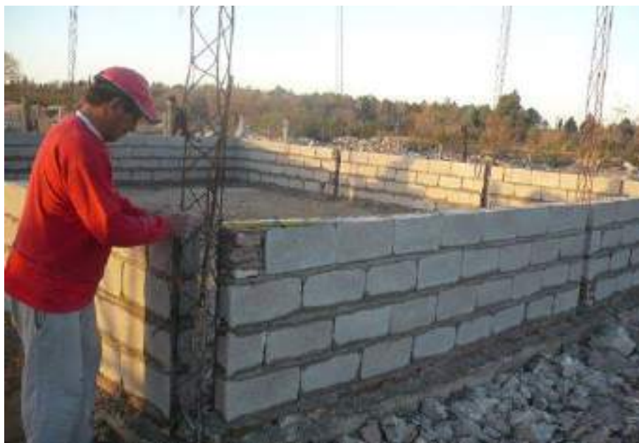
Fotografía 3. Construcción del galpón de la cooperativa Todo Sirve.
